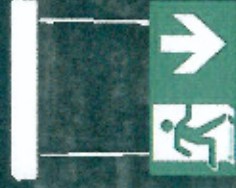
Lampa kierunkowa- montaż pod belką
