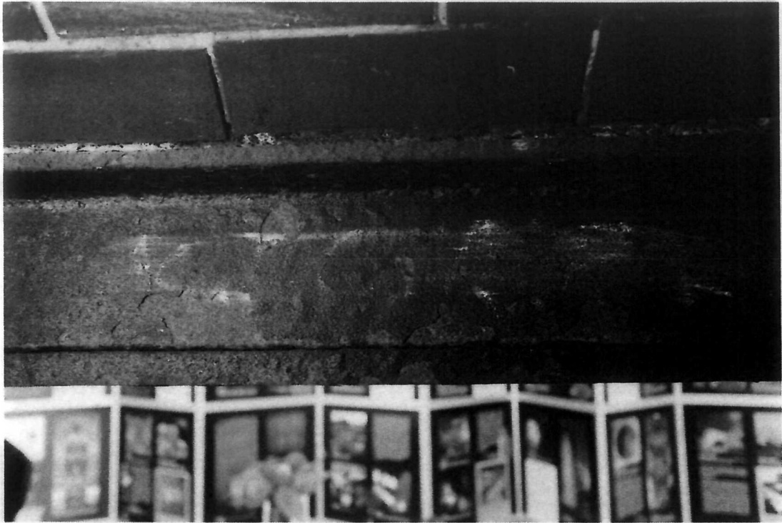
Fot. 13. Sala kominkowa, Zamek książęcy w Oleśnicy, detal – stan zachowania.
