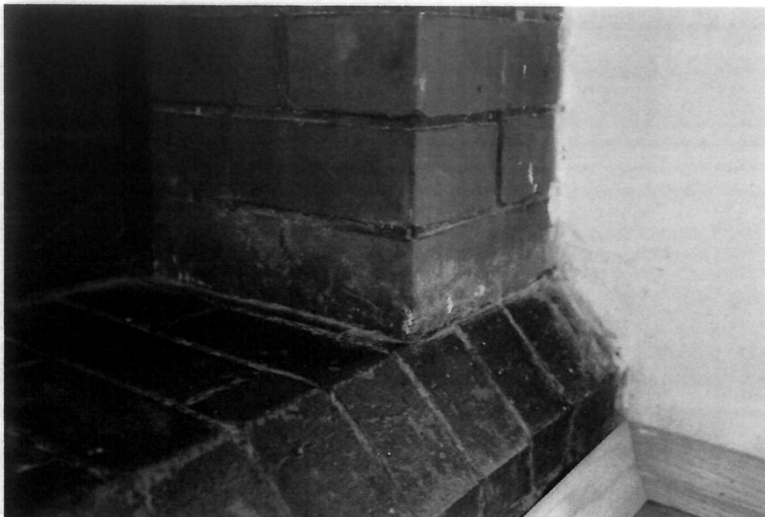
Fot. 11. Sala kominkowa, Zamek książęcy w Oleśnicy, detal – stan zachowania.
