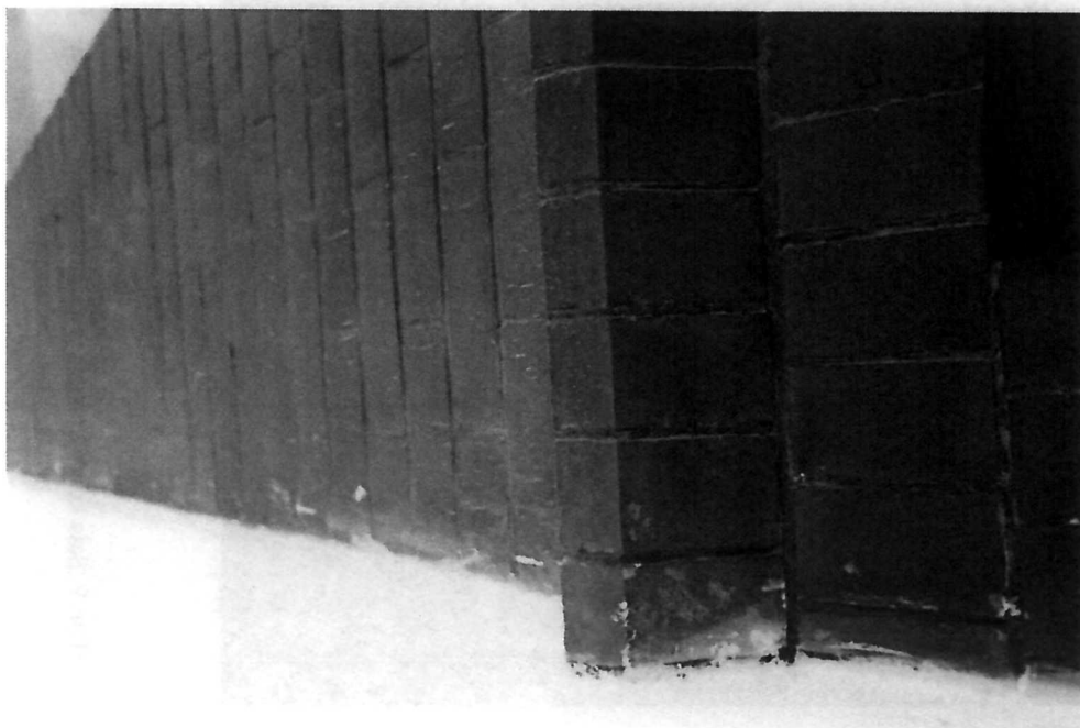
Fot. 7. Sala kominkowa, Zamek książęcy w Oleśnicy, detal – stan zachowania.
