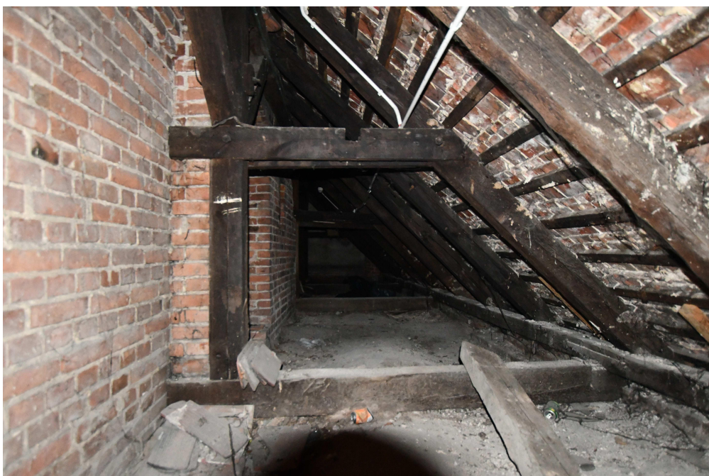
Fot. 7: Więźba skośnego dachu przyległego do południowo – wschodniej ściany skrzydła D
